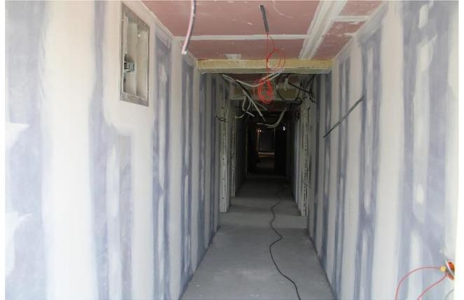
Création du désenfumage du couloir vers le PASA avec le perçage de la dalle, mise en place d'une gaine d'aspiration et montage du faux plafond
