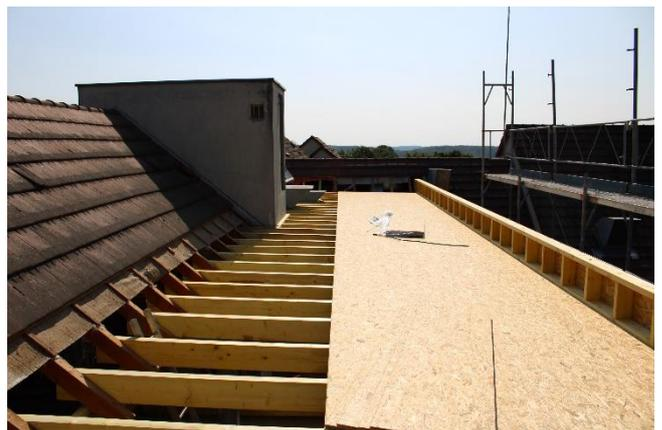
Les travaux sont réalisés par section et en fonction de la météo pour éviter l'ouverture de la toiture sur une trop longue période.
