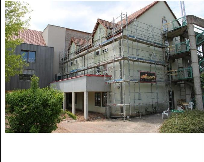
Prolongement de la dalle béton. Réhausse des murs en ossature bois
