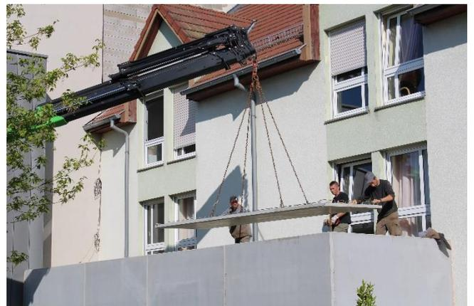
Les fondations sont creusées puis coulées en béton. Coffrage et béton coulés sur place pour les montants. La dalle de la cour-sive est réalisée en béton préfabriqué.
