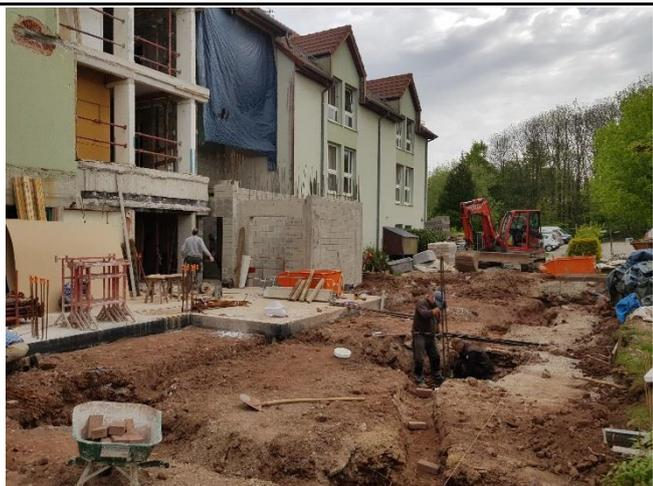
Entre les deux cages d'ascenseur, les maçons démarrent le coffrage de l'escalier encoisonné.
