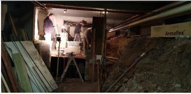
Réalisation de la cage d'ascenseur pour l'ascenseur qui descendra jusqu'au sous-sol, par l'entreprise de gros-œuvre, SUSS
