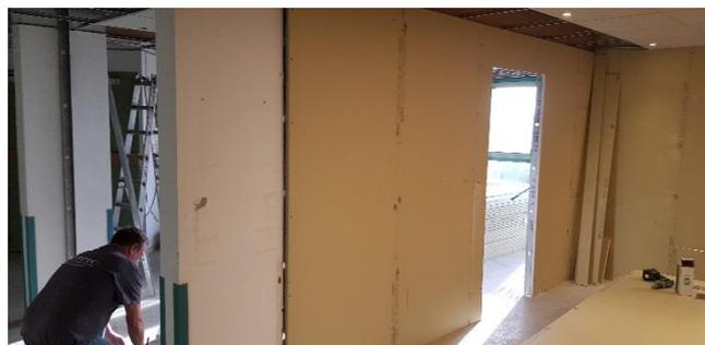
Mise en place d'une cloison provisoire par le plaquiste SEPPIC, pour isoler les parties communes du chantier et permettre de travailler en toute sécurité
